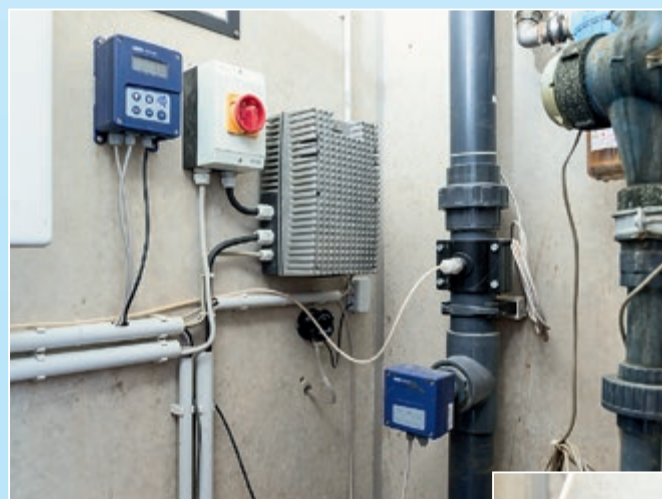
Der Leitwert bestimmt nach wie vor die Abschlammrate. Durch eine Anhebung des Leitwerts auf 30 mS/cm erfolgt das Abschlämmen aber in einem geringeren Umfang.
